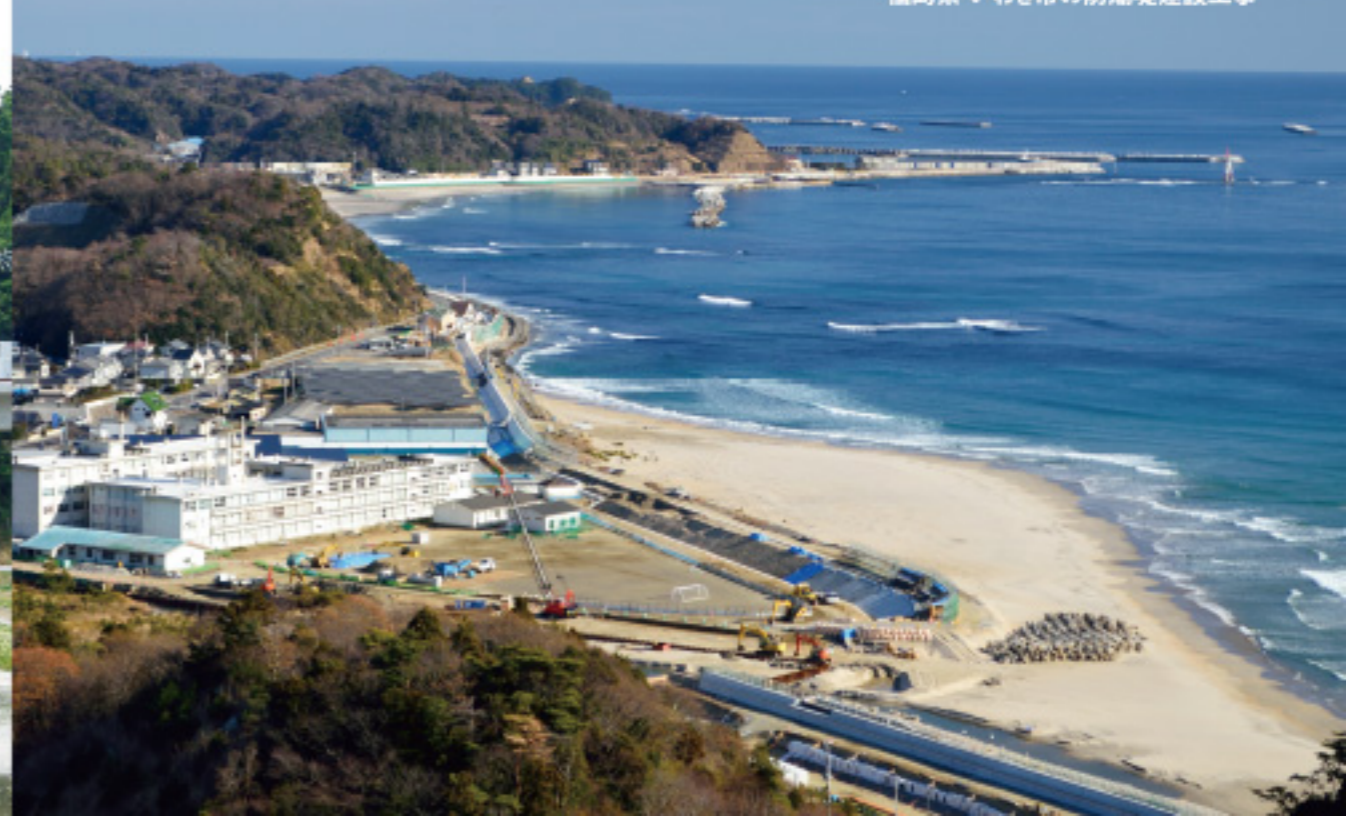
福島県 いわき市の防潮堤建設工事
