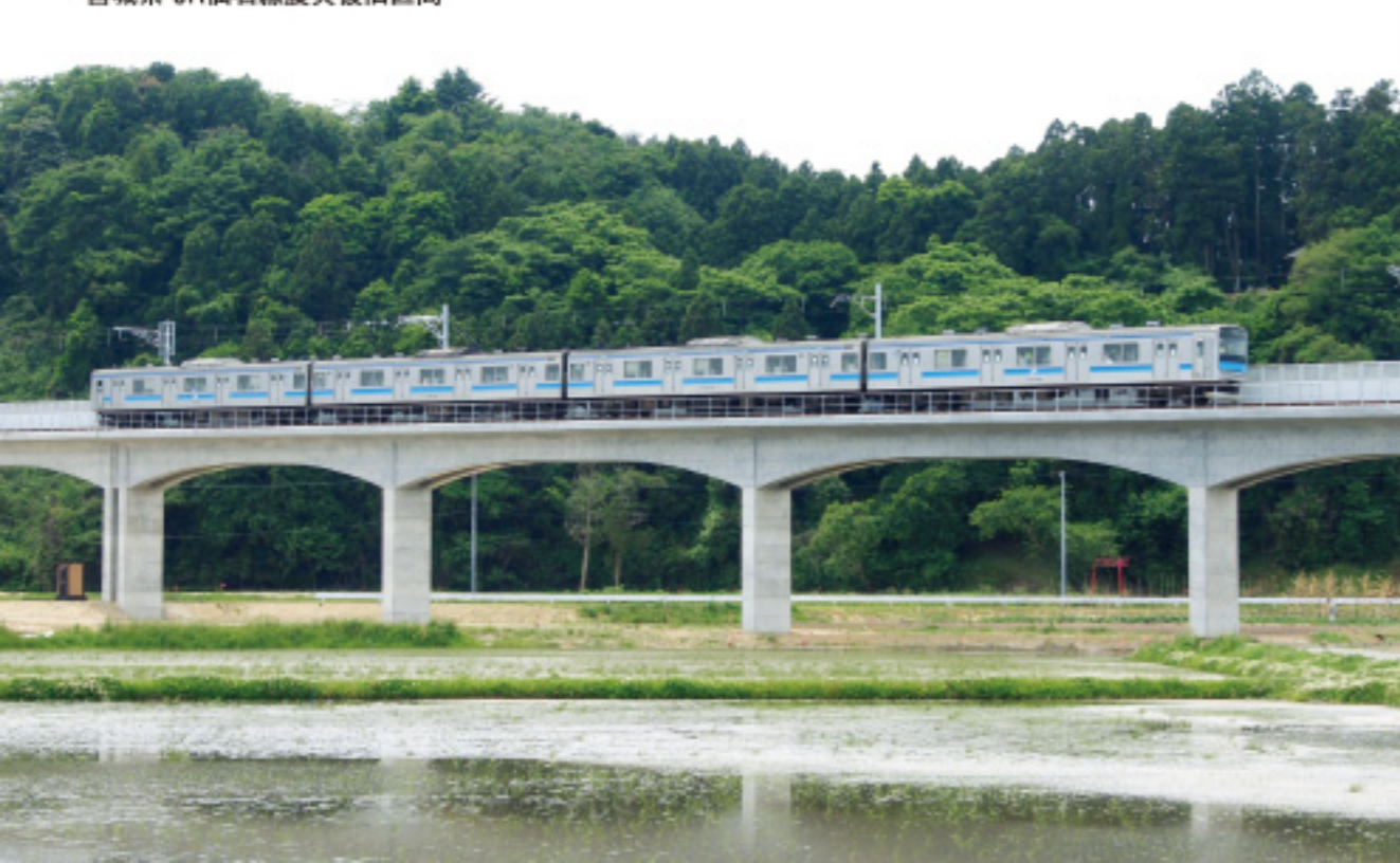
宮城県 JR仙石線震災復旧区間
